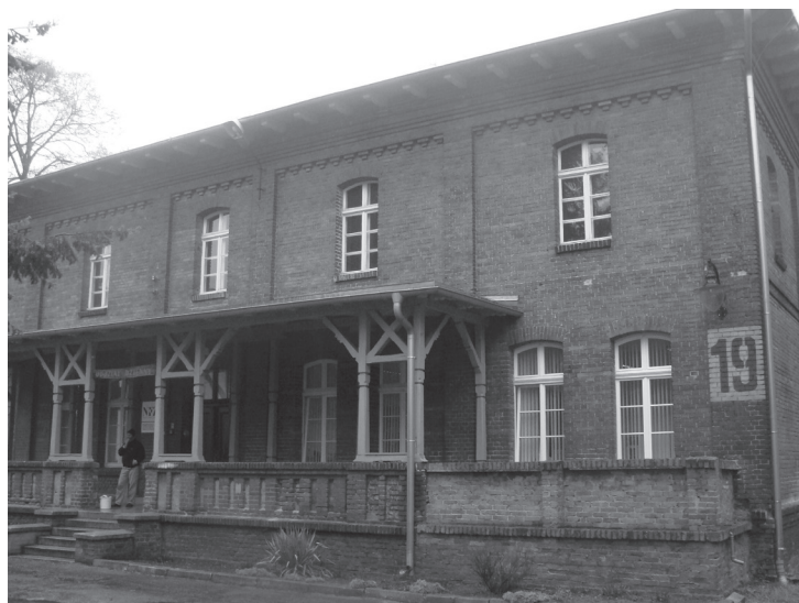
Il. 7. Pawilon nr 19 w „Dziekance”. W budynku tym mieści się działające przy szpitalu muzeum, które zajmuje pomieszczenia znajdujące się na piętrze. Z racji braku wydzielonej klatki schodowej jedyna droga do muzeum prowadzi przez znajdujący się na parterze dzienny oddział psychiatryczny. Fot. własna.
