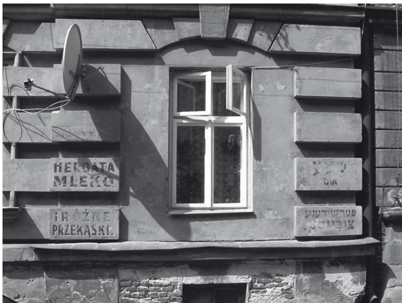
Fot. 1. Fasada kamienicy przy ul. Goldhammera (początek lat 90. XX w.)
